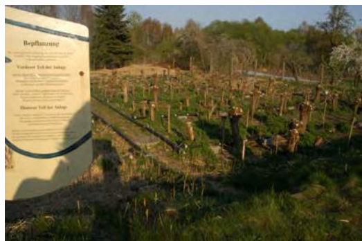
Įrengta nuotekų valymo sistema po gluosnių medienos derliaus „nuėmimo“. Nuotraukos autorius: Achimas Eckeris.
