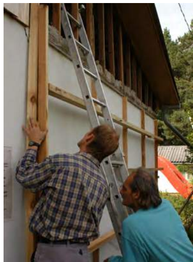
Namo apšiltinimo darbai, naudojant putstiklį ir celiuliozės pluoštą. Nuotraukos autorius: Achimas Eckeris.
