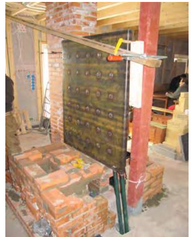
Židinio mūrijimo darbai. Vandens šildymui skirta dalis patalpinta židinio viduryje. Nuotraukos autorius: Ella Suhonen.
