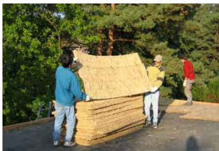
Žaliojo stogo šilumos izoliaciją užtikrins skydeliai iš nendrių. Nuotraukos autorius: Achimas Eckeris.
