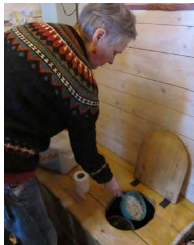
Pasinaudojus kompostiniu tualetu, užpilamos pjuvenos. Nuotraukoje pavaizduota klozeto vieta, kurioje atskiriamos kietosios ir skystosios atliekos, padaryta iš plastikinio piltuvėlio. Nuotraukos autorius: Mia Saloranta.
