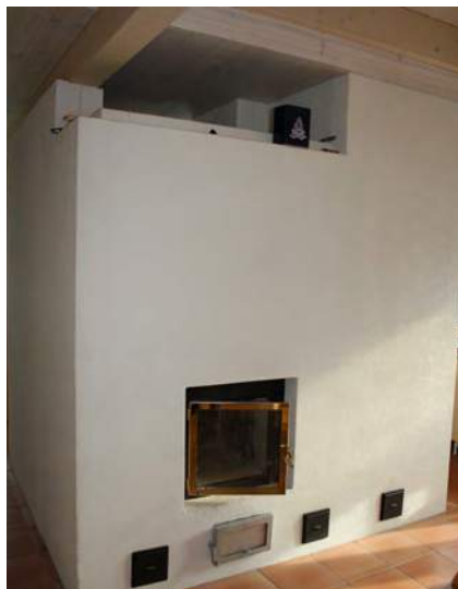
Židinytis ir jo apačioje įrengtos šilumos sklidimui skirtos angos. Nuotraukos autorius: Ella Suhonen.
