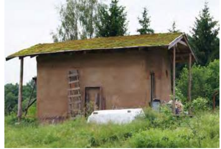
Green moss roof at Laimis Ecovillage. Photo by Živilė Gedminaitė-Raudonė.
